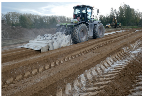
Malaxeur porté sur tracteur agricole (chantier expérimental de Vlassenbroek - photo Lhoist)
