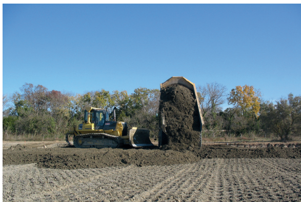
Approvisionnement du sol traité au dumper et réglage d'une couche au bulldozer (chantier Salin de Giraud - photo Lhoist)
