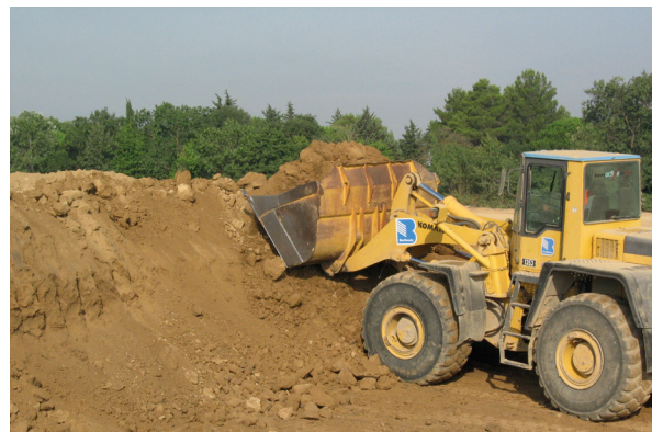
Reprise en butte au chargeur sur dépôt provisoire pour alimentation d'une centrale de traitement (photo DigueELITE)
