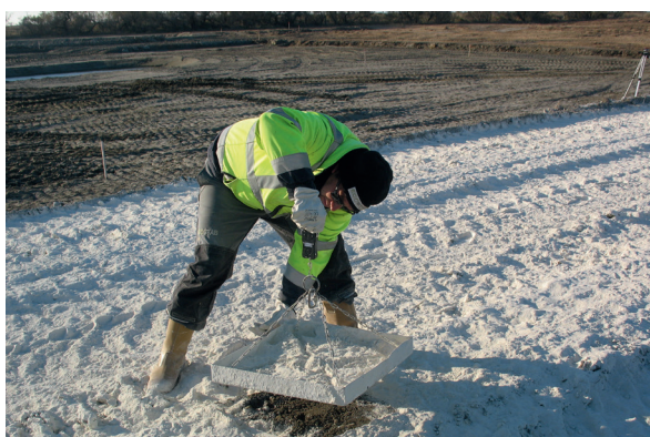
Contrôle par pesée de bac de la masse surfacique de chaux épandue (photo Lhoist)
