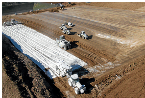
Figure 35 : Vue générale d'un chantier de traitement de sol avec de gauche à droite un épandeur de liant, deux malaxeurs automoteurs et trois compacteurs (photo Entreprise Lhotellier)
