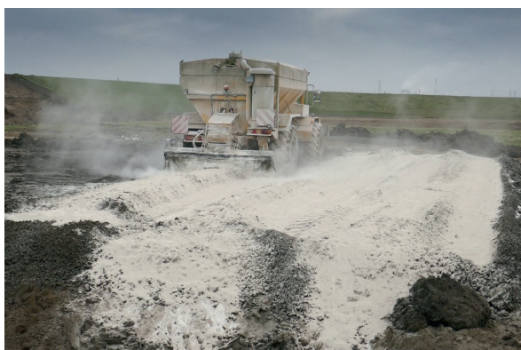
Épandage de la chaux sur sol A2 humide avec épandeur à dosage volumétrique (photo Lhoist)
