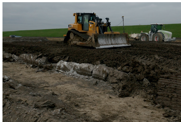
Reprise de la planéité d'une couche de sol naturel au bulldozer guidé par GPS après une séquence d'arrosage et de malaxage (photo Lhoist)
