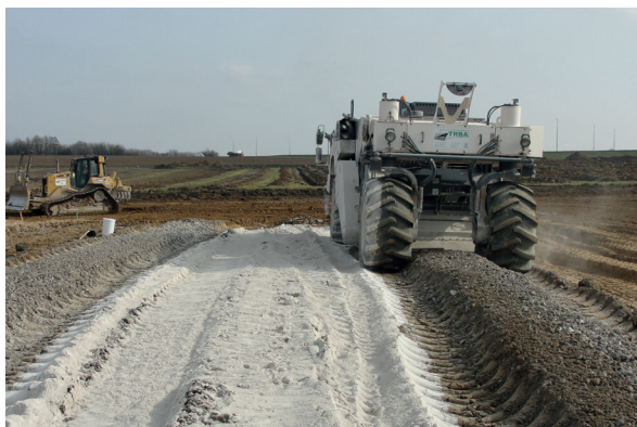
Malaxeur automoteur (photo Lhoist)
