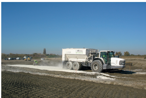
Épandage de la chaux sur la plate-forme dédiée au traitement de sol avec épandeur à dosage volumétrique et contrôle pondéral (chantier Salin de Giraud novembre 2017 – photo Lhoist)
