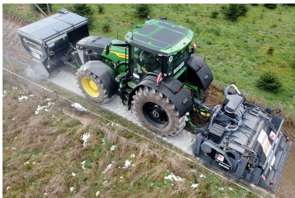
Regroupement des fonctions d'épandage et de malaxage : le matériel est tracté par un tracteur agricole (photo Streumaster)
