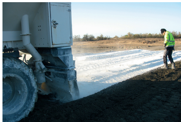
Contrôle visuel de l'épandage de la chaux sans émission de poussières (photo Lhoist)
