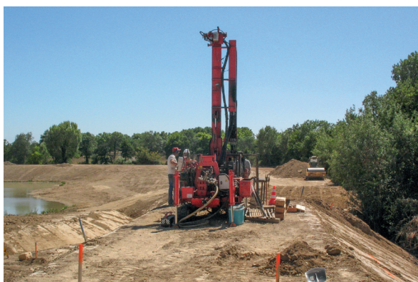
Réalisation d'un forage pour piézomètre (photo DigueELITE)
