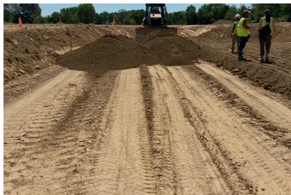
Figure 50 : Fermeture et orniérage de la couche sous-jacente par le trafic des engins de transport (photo DigueELITE)
