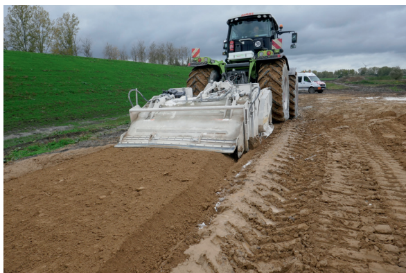
Malaxage du sol naturel après arrosage (chantier expérimental de Vlassenbroek - photo Lhoist)
