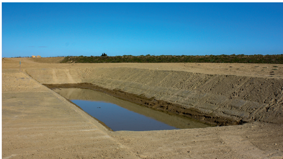
Bassin de rétention d'eau étanché par 2 couches compactées de sol traité (photo DigueELITE)
