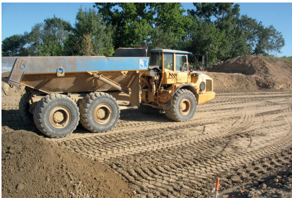
Circulation d'un tombereau sur sol A1 chantier du Vidourle (photo DigueELITE)
