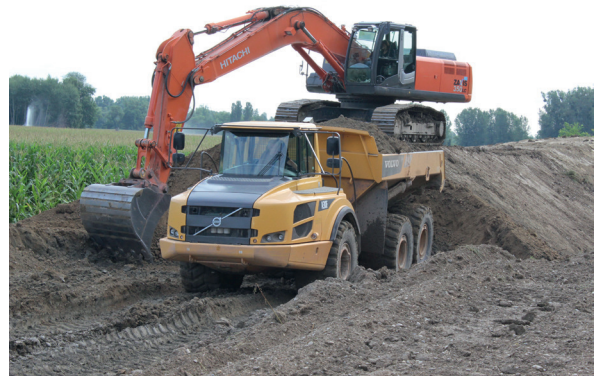
Reprise de sol à partir d'un dépôt provisoire (photo Lhoist)
