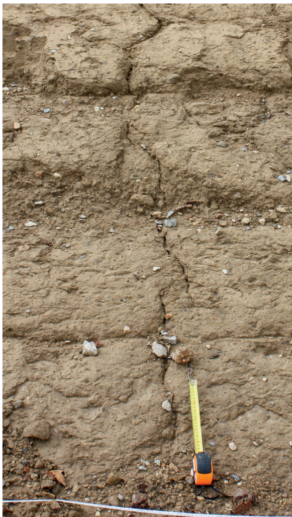
Fissures transversales sur le sol traité (à gauche) et sur le sol non traité (à droite) - Prise de vue 16/09/2016, construction + 422 jours (photos DigueELITE)
