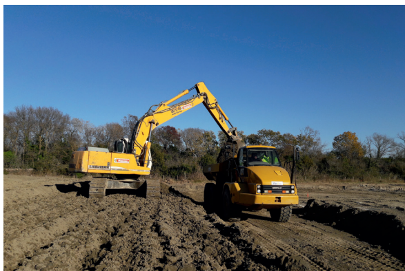
Reprise en butte à la pelle de sol naturel sur dépôt provisoire avec homogénéisation (chantier Salin de Giraud novembre 2017 - photo Lhoist)
