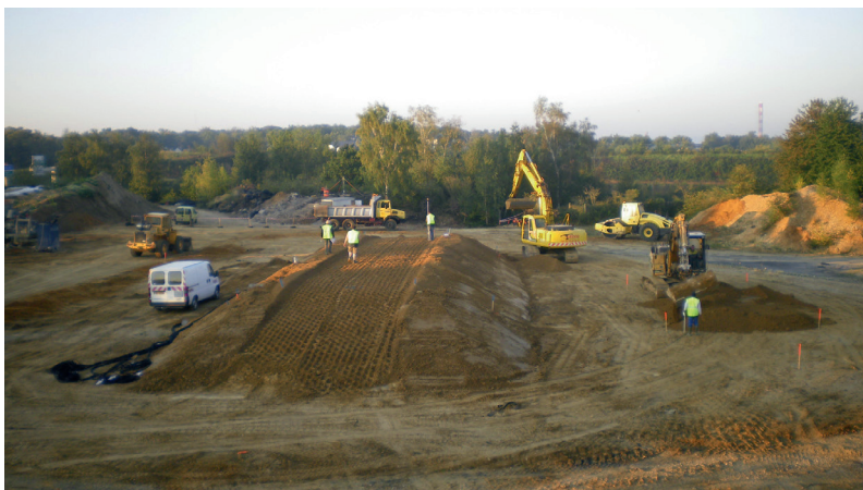
Figure 26 : Digue sèche expérimentale de Rouen – vue générale de la digue en construction (photo Lhoist)
