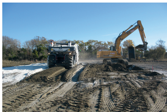
Reprise de sol traité à la pelle sur plate-forme (chantier Salin de Giraud novembre 2017 – photo Lhoist)
