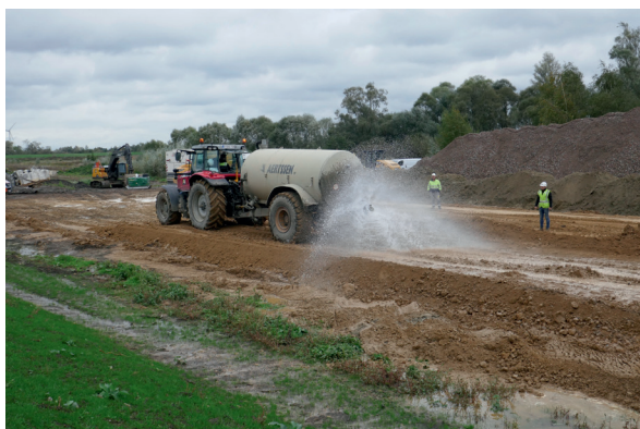
Arrosage d'une plate-forme de sol naturel avec une arroseuse de surface de type « queue de carpe » (chantier expérimental de Vlassenbroek - photo Lhoist)
