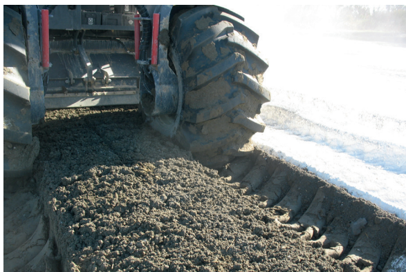
Vue de la mouture d'un sol A1 traité à 2 % CaO après une passe de malaxeur (chantier Salin de Giraud novembre 2017- photo Lhoist)
