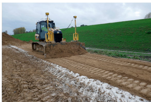
Réglage d'une couche de sol traité sur planche d'essais au bulldozer équipé d'un système GPS altimétrique (chantier expérimental de Vlassenbroek - photo Lhoist)
