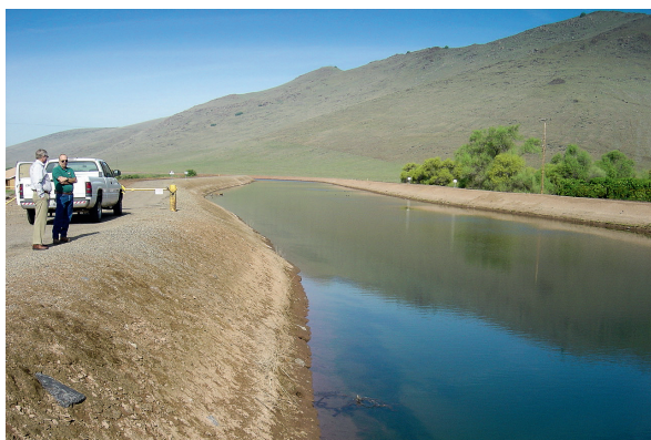
Berges en sol traité à la chaux (photo Lhoist)
