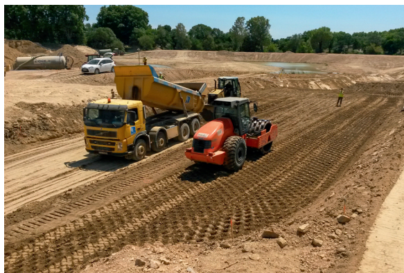
Mise en œuvre et compactage en ateliers parallèles (chantier du Vidourle - photo DigueELITE)
