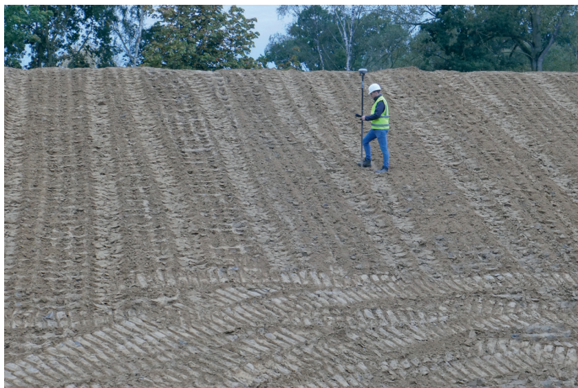
Figure 63 : Réalisation d'un levé topographique final par GPS (chantier expérimental de Vlassenbroek - photo Lhoist)
