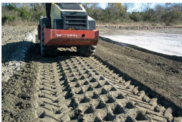
Empreintes de pieds de compacteur VP5 bien formées et compactées sur sol A1 traité à 2 % CaO à W = W_{OPN} + 4\% (photo Lhoist)
