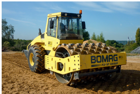
Figure 48 : compactage avec un compacteur de classe VP5 d'un ouvrage en sol A2 traité à 3 % de chaux (photo Lhoist)
