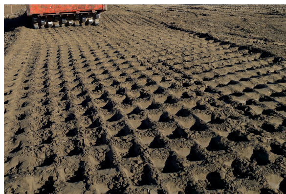
Empreintes de pieds de compacteur VP5 friables à cause d'une teneur en eau trop faible sur sol A1 traité à 2 % CaO à W = W_{OPN} (photo Lhoist)
