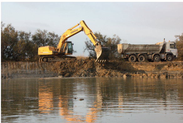
Extraction d'un gisement à la pelle avec homogénéisation (chantier Salin de Giraud novembre 2017 - photo INRAE)
