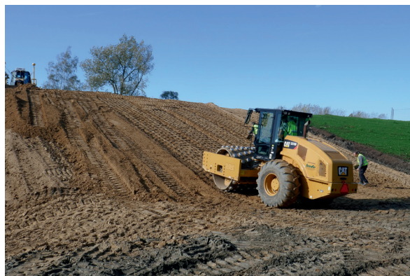
Figure 47 : Compactage d'une couche suivant la pente de talus de 3H/1V (chantier expérimental de Vlassenbroek - photo Lhoist)
