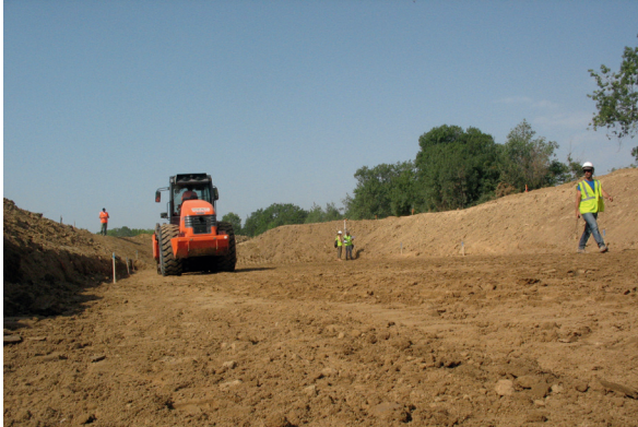
Compaction d'un fond de fouille (photo DigueELITE)
