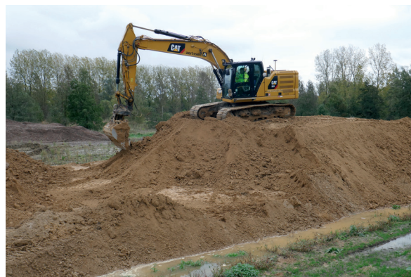
Homogénéisation à la pelle de sol naturel sur dépôt provisoire (chantier expérimental de Vlassenbroek - photo Lhoist)
