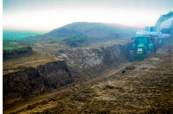
Remblayage d'une clé d'ancrage (photo entreprise Lhotellier)
