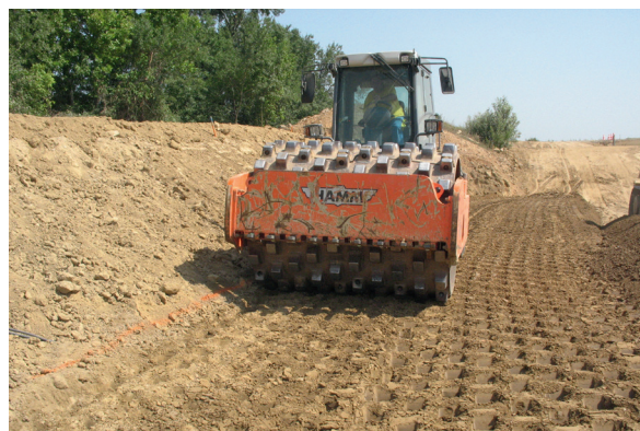
Compactage en épaulement sans redans en appui sur le talus d'un ouvrage existant (photo DigueELITE)
