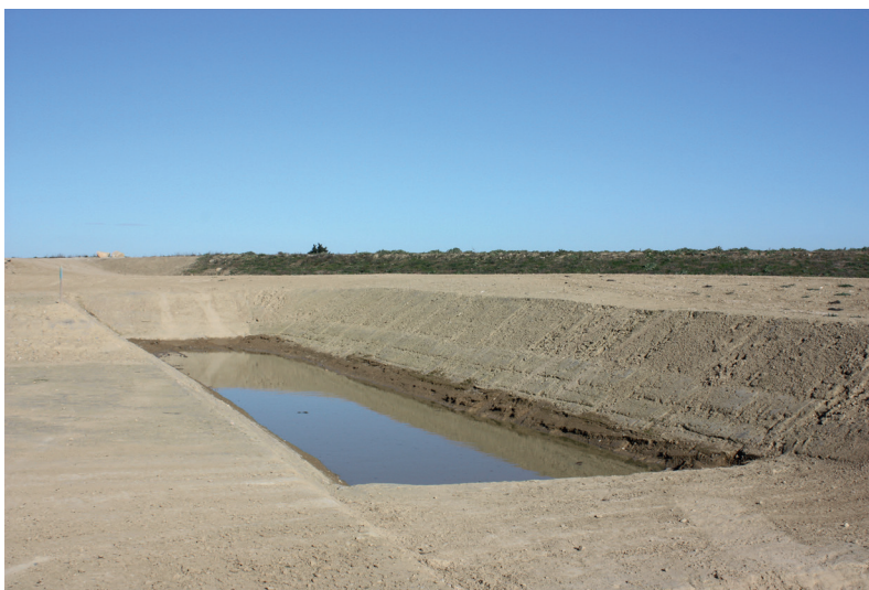
Figure 23 : Ouvrage en sol traité à la chaux dans son environnement - Chantier du Vidourle : vue du bassin en sol A1 traité à 2 % de chaux après 6 mois (photo INRAE du 04-02-2016)
