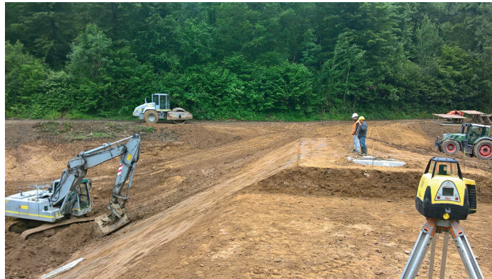
Figure 54 : Retaillage des talus d'un ouvrage de retenue collinaire (photo Entreprise Lhotellier)
