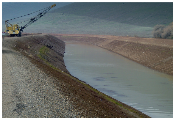
Berges en sol traité à la chaux ; nettoyage de surface après vidange du canal (photo Lhoist)
