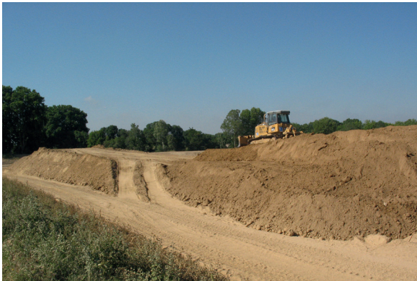
Réalisation d'un dépôt provisoire (photo DigueELITE)
