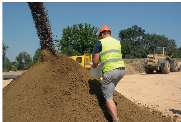
Vue de la mouture d'un sol A1 traité à 2 % CaO en sortie de centrale (chantier expérimental du Vidourle Projet DigueELITE)
