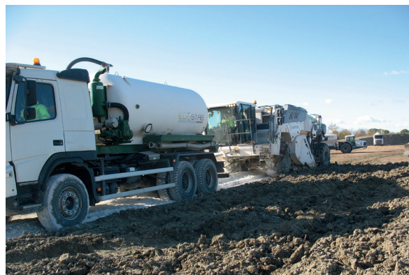
Regroupement des fonctions d'arrosage et de malaxage : l'arroseuse est poussée par le malaxeur automoteur et l'incorporation d'eau se fait directement dans la cloche du malaxeur (chantier Salin de Giraud novembre 2017 – photo Lhoist)
