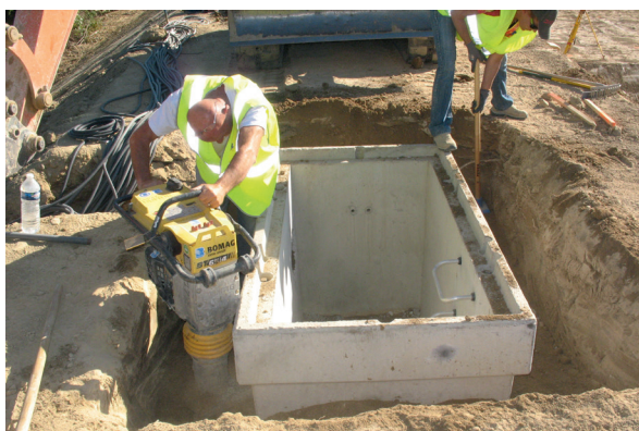
Compactage à la pilonneuse vibrante PN3 autour d'une chambre (photo DigueELITE)
