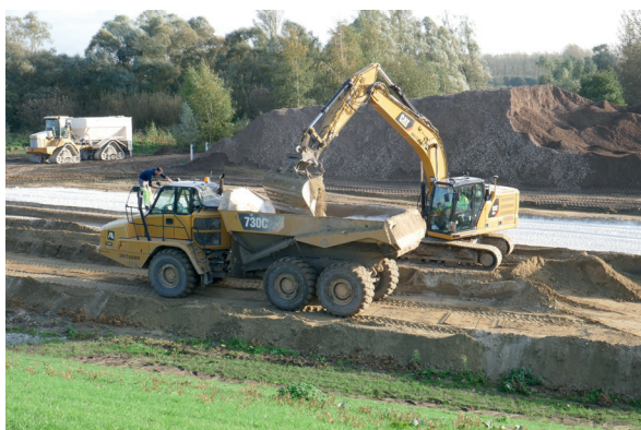
Reprise de sol traité à la pelle sur plate-forme avec guidage GPS ; à noter le cordon au premier plan non repris car non traité (chantier expérimental de Vlassenbroek - photo Lhoist)
