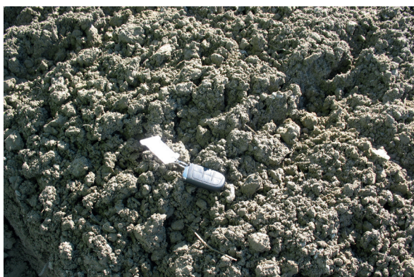
Détail de la mouture d'un sol A1 traité à 2 % CaO après une passe de malaxeur (chantier Salin de Giraud novembre 2017 – photo Lhoist)
