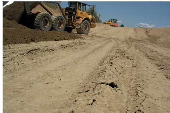
Exemple de fluage créé lors d'un transport par camion benne 6x8 sur sol A1 chantier du Vidourle (photo DigueELITE)
