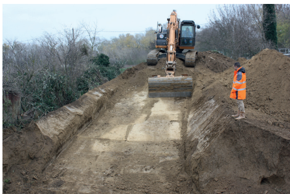
Terrassement d'un ouvrage existant (photo INRAE)
