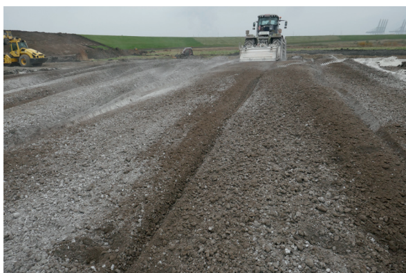
Vue de la mouture d'un sol A2 traité à 4 % CaO après une passe de malaxeur (photo Lhoist)
