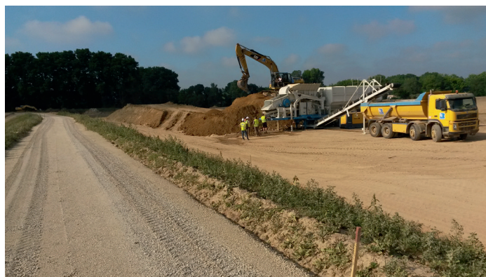
Vue générale : Dépôt provisoire de sol naturel et centrale de traitement mobile (chantier du Vidourle juillet 2015) (photo DigueELITE)
