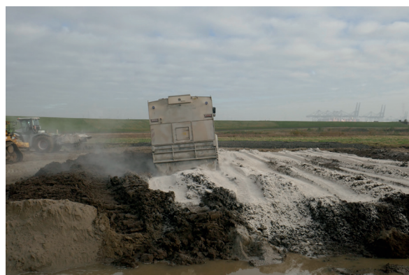
Épandage de la chaux sur sol A2 humide avec épandeur sur chenilles à dosage volumétrique et contrôle pondéral (photo Lhoist)
