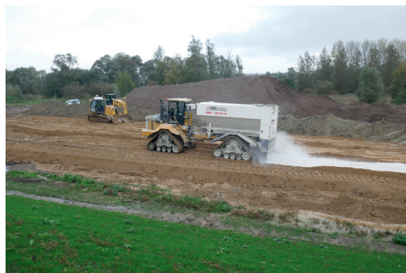
Épandage de la chaux sur la plate-forme dédiée au traitement de sol avec épandeur sur chenilles à dosage volumétrique et contrôle pondéral (chantier expérimental de Vlassenbroek - (photo Lhoist)
