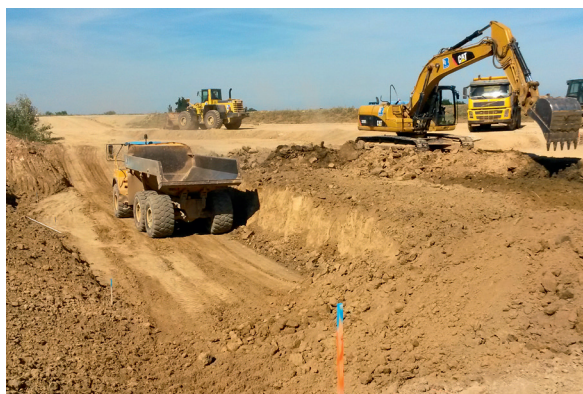
Terrassement d'un gisement de sol A2 (photo DigueELITE)
