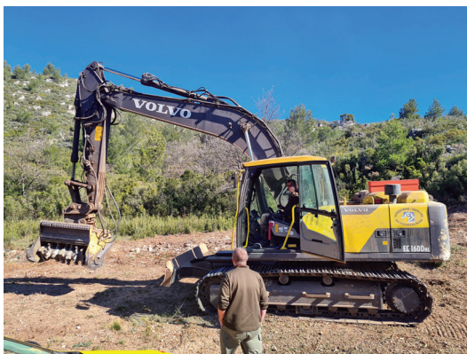
Figure 15. Pelle mécanique équipée d'un broyeur sur chenille à bras mobile © Arthur Boschet/INRAE
