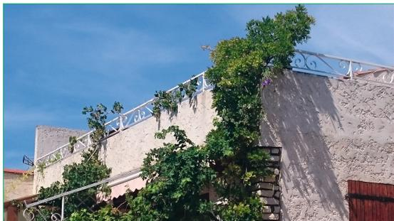
Figure 6. Plante grimpante jouant le rôle de combustible échelle
