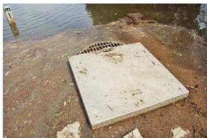
Déchets bouchant l'exutoire © Hunt et al., 2011
