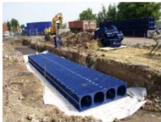
Photo 9 : Mise en oeuvre d'une chaussée à structure-réservoir (Copyright : CA du Douaisis)
