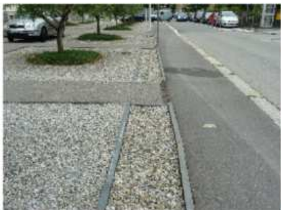
Photo 7 : Tranchée drainante (Copyright : CETE de l'Est – A. Gerolin)
