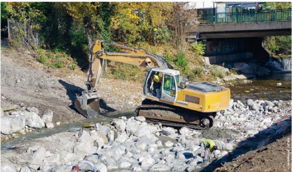
Vue générale d'un ouvrage de génie biologique à l'aval d'un pont (enrochement en pied de berge et végétalisation).
