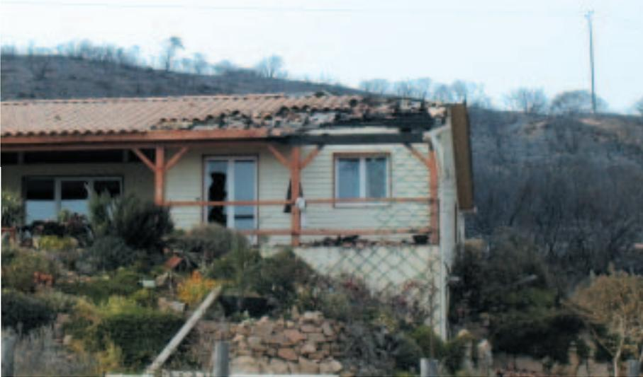
Maison endommagée par une saute de feu sur une ouverture dans la toiture
