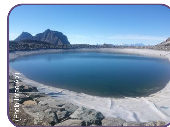
Evaluation de la durabilité des DEG des retenues d'altitude
