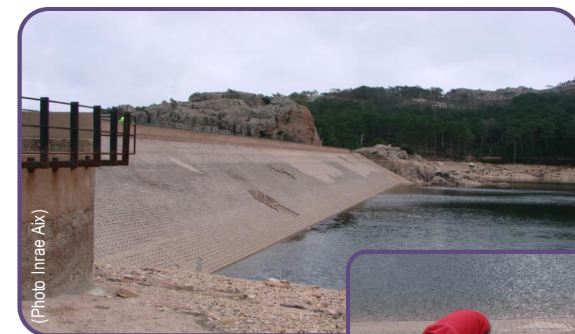
Prélèvement de géomembrane sur un barrage
