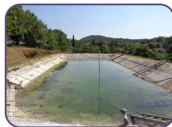
Bassin expérimental (géosynthétiques pour la détection de fuites)
