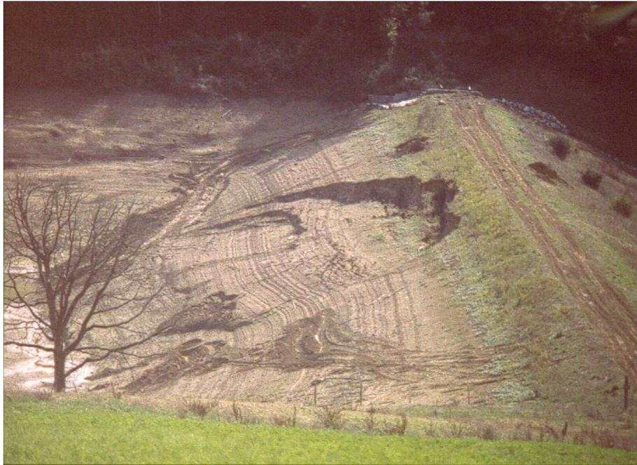
Figure 8 : Glissement de parement amont (Source : Irstea)
